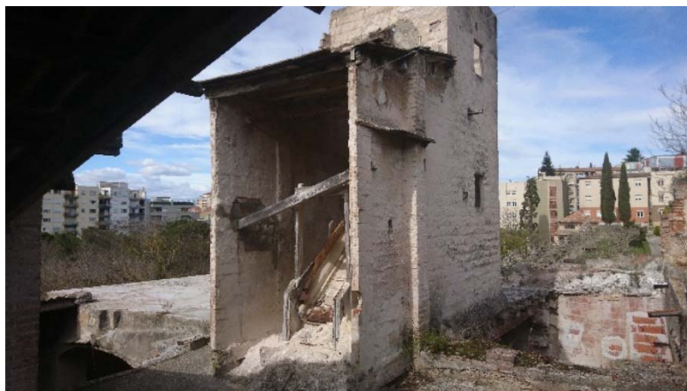
Forn de calç al Passatge dels Picapedrers
